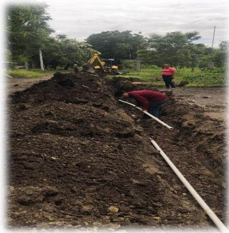
2. Se instaló 230 ml. de tubería hidráulica en PVC de 1 ½" para abastecer de agua potable en la calle Arcos del Triunfo de la colonia Los Arquitos.
