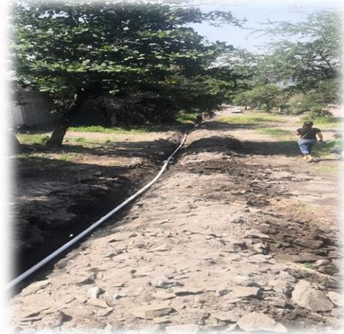
3. Instalación de 490 ml. De tubería hidráulica en pvc de 2" para abastecer de agua potable a una parte de la comunidad de Rancho Seco de nuestra Cabecera Municipal.
