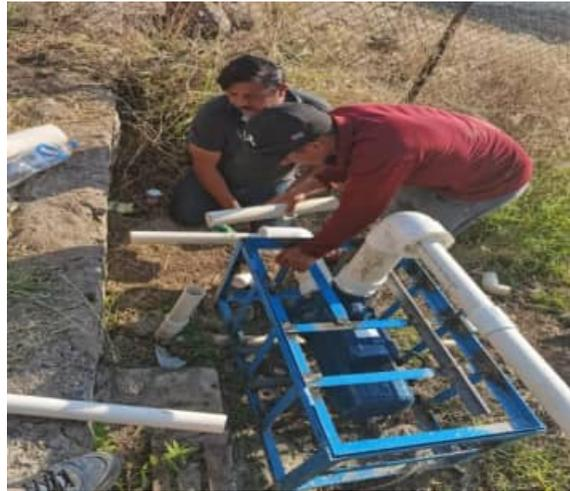
2.- **Equipo de bombeo colonia Lázaro Cárdenas:** Instalamos un transformador de 150 KVA y una electrobomba nueva medina de 150 HP. Con dos líneas de alimentación cada una de 1/0 AWG. Se instalaron 74 metros de columna de 8", con todo lo anterior logramos suministrar la cantidad de agua de acuerdo a la NOM a nuestros usuarios.
