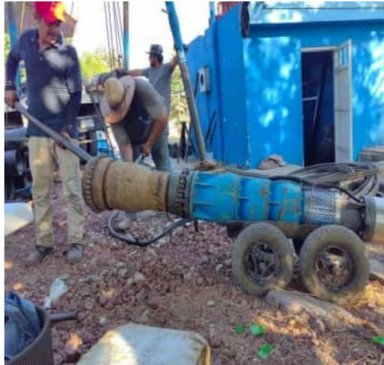
**3.- Mantenimiento Equipo Fraccionamiento Bugambilias;** Se instaló una electrobomba sumergible de 30 HP, con esta electrobomba aumentará el suministro de agua en beneficio de los habitantes de esta colonia y tendremos un ahorro de energía eléctrica.
