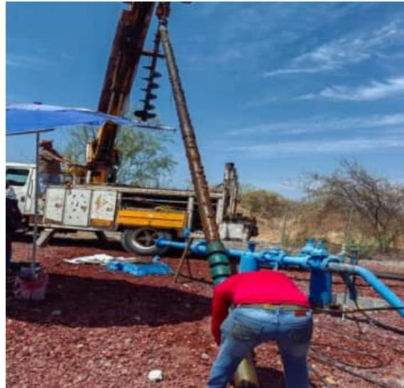
**4.- Mantenimiento Equipo de Bombeo Colonia Buenos Aires:** Se agregó un impulsor a la columna de 10", se le dio mantenimiento preventivo a la columna, se le cambiaron todos los bujes al cuerpo hidráulico, con estas acciones logramos tener más caudal y presión en la red de distribución de las colonias Generalísimo Morelos, La Fuente, Josefa Ortiz de Domínguez, Buenos Aires, Zaragoza, Tierras Blancas 1, Porfirio Ponce y parte baja de la Rubén Romero.
